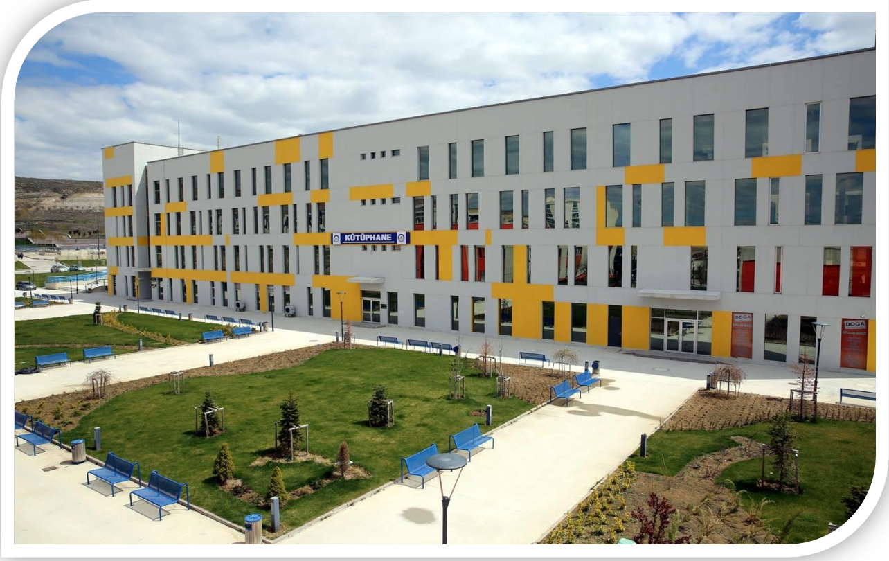
Şekil 6. Üniversitemiz Kütüphane Binasından Bir Kesit.
